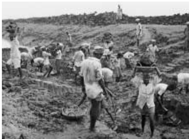
Excavación del canal.
